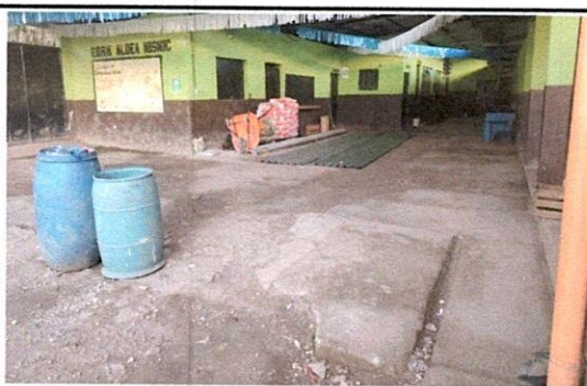
Foto 5: Reparación de piso de torta de concreto frente a la cocina.
