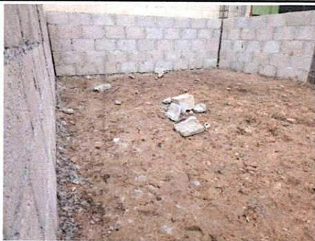
Foto 1: Seguimiento de pared, colocación de piso y repello de paredes en aula, dirección y baño.
