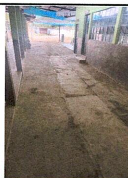
Foto 6: Reparación de piso de torta de concreto frente al aula de tercero y aula tecnológica.
